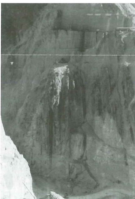
KARUN III - Widerlagerbereich Gewölbestaumauer, 220 m hoch
