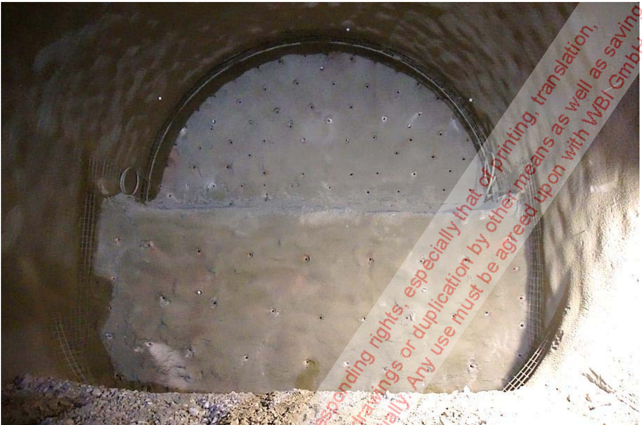
Bild 8: U-Profil: Ortsbrustaufnahme
