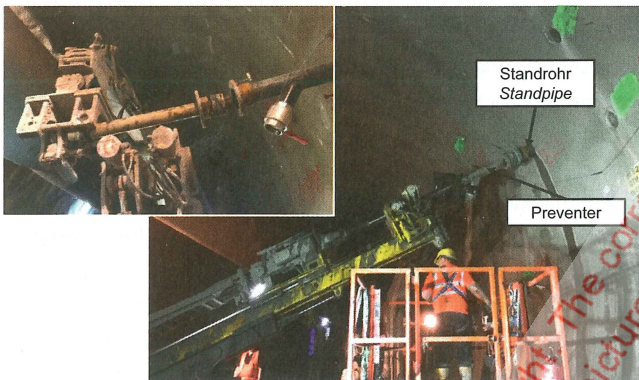
12 Bohren und Injizieren mit Preventer
