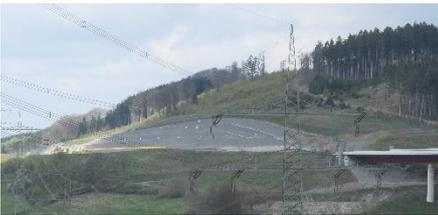
Da die im Hang herrschende natürliche Sickerströmung zu einer Belastung der Böschungssicherung führen würde, wurden in zwei Ebenen 35 m lange und mit 2 % abwärts geneigte Drainagebohrungen hergestellt. Dadurch wird der Hangwasserspiegel so weit abgesenkt, dass keine die Standsicherheit der Böschung gefährdenden Strömungskräfte auftreten. Das auf den Bermen versickernde Niederschlagswasser wird über kurze Drainagebohrungen sowie die Perforation der Spritzbetonschale schadlos abgeführt.
