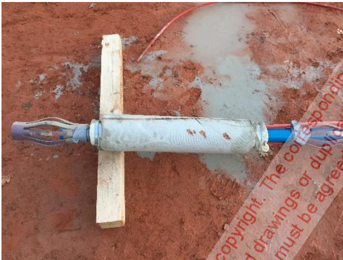
Abb. 4: Gewebepacker am PVC-Rohr befestigt
