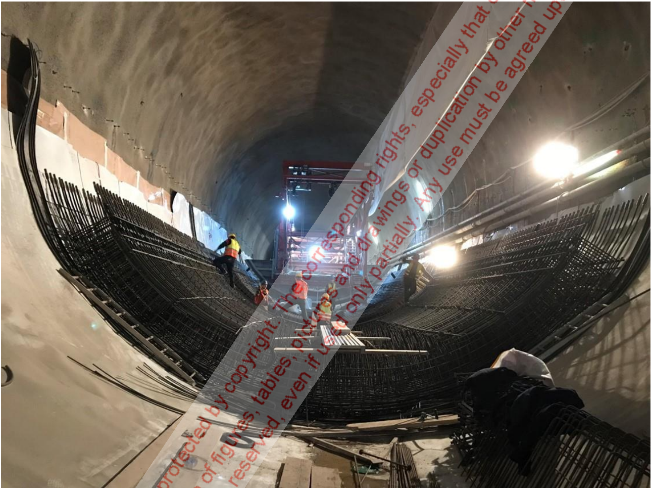
Bild 12: Einbau der Sohlgewölbebewehrung
