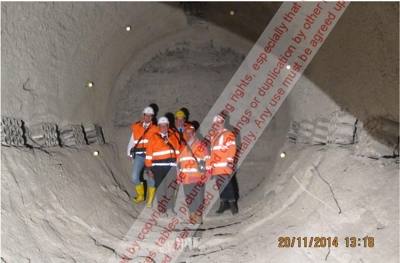
Bild 24: Erkundungsstollen mit Knautschelementen
