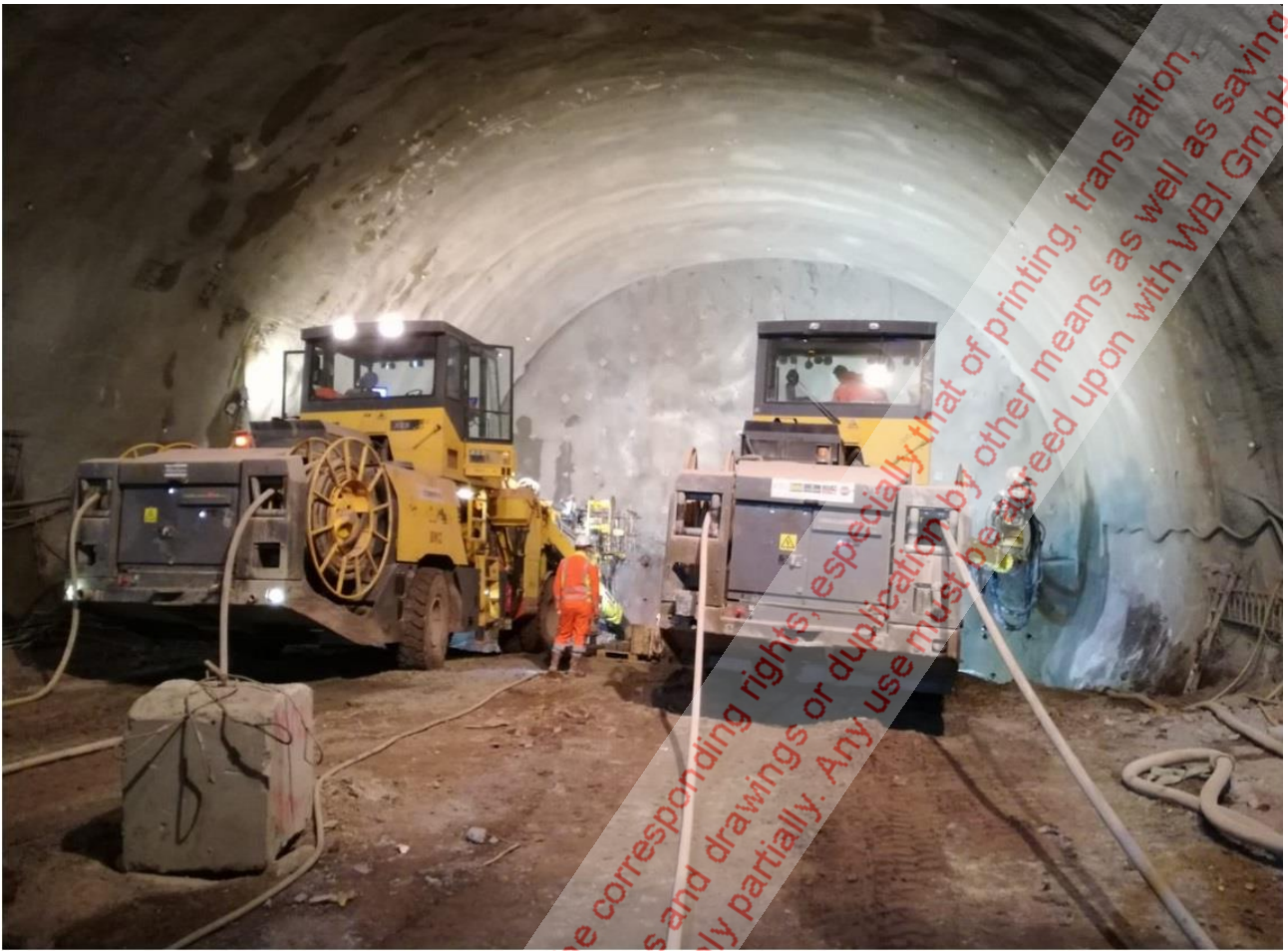
Bild 9: Herstellung Ortsbrustanker
