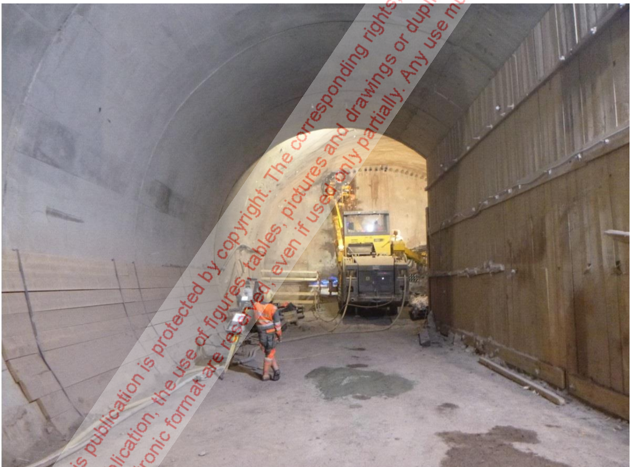
Bild 8: Herstellung Rohrschirm
