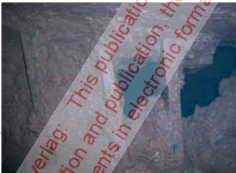
Neuer Schlüchterner Tunnel Verklebung Öffnungen im Tonstein Clogging of openings in claystones
