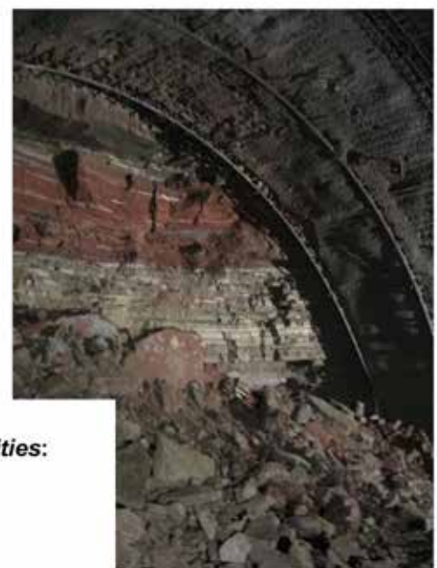
Ortsbrust Buntsandstein, Tunnel Höllberg Temporary face Bunter tunnel Höllberg
