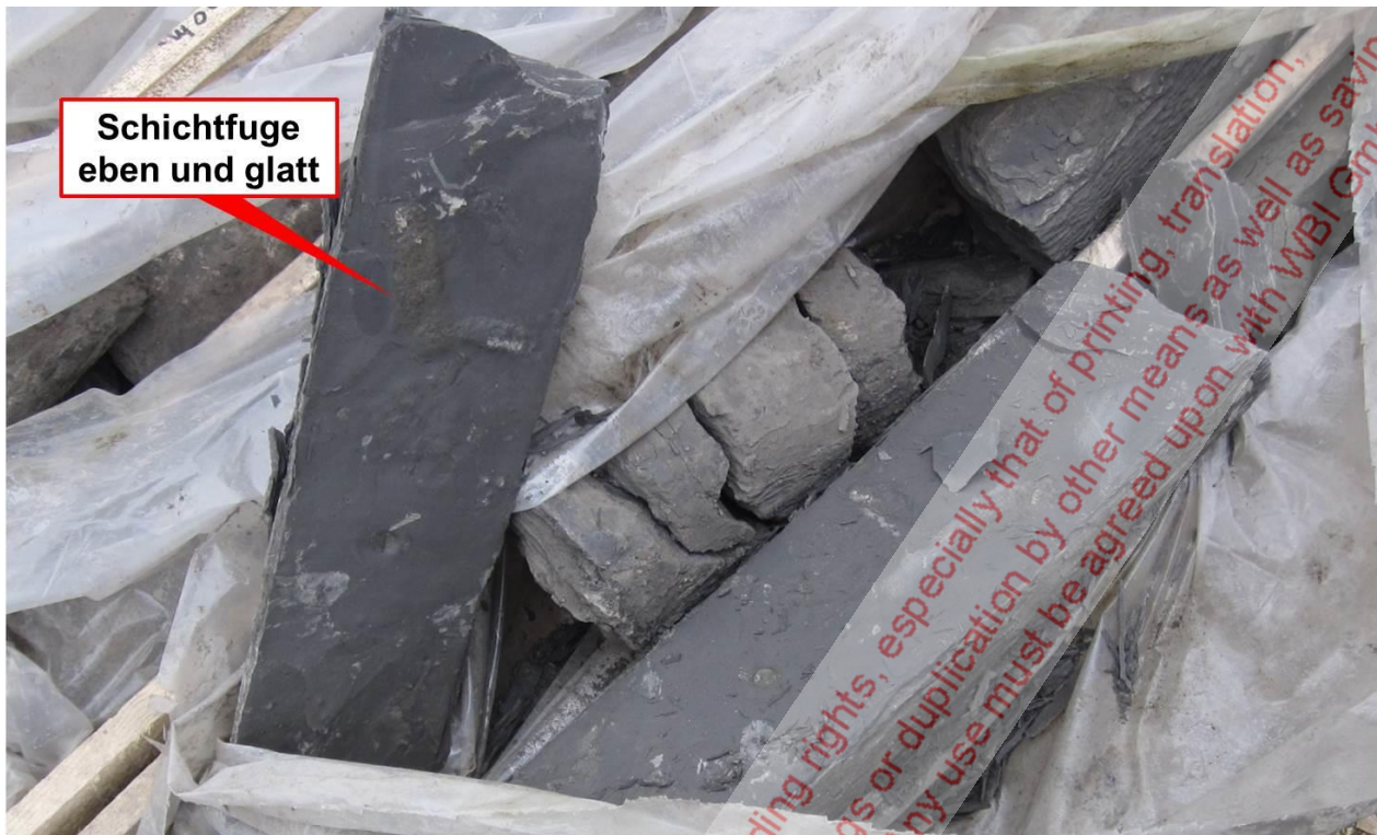
Bild 8: Horizontale Schichtfuge im ZOP
