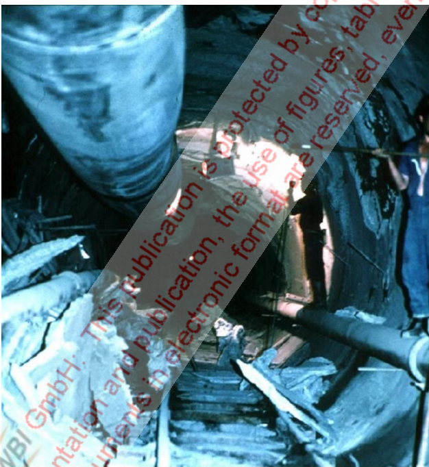
Bild 3: Druckhaftes Gebirge und nachgiebiger Ausbau
