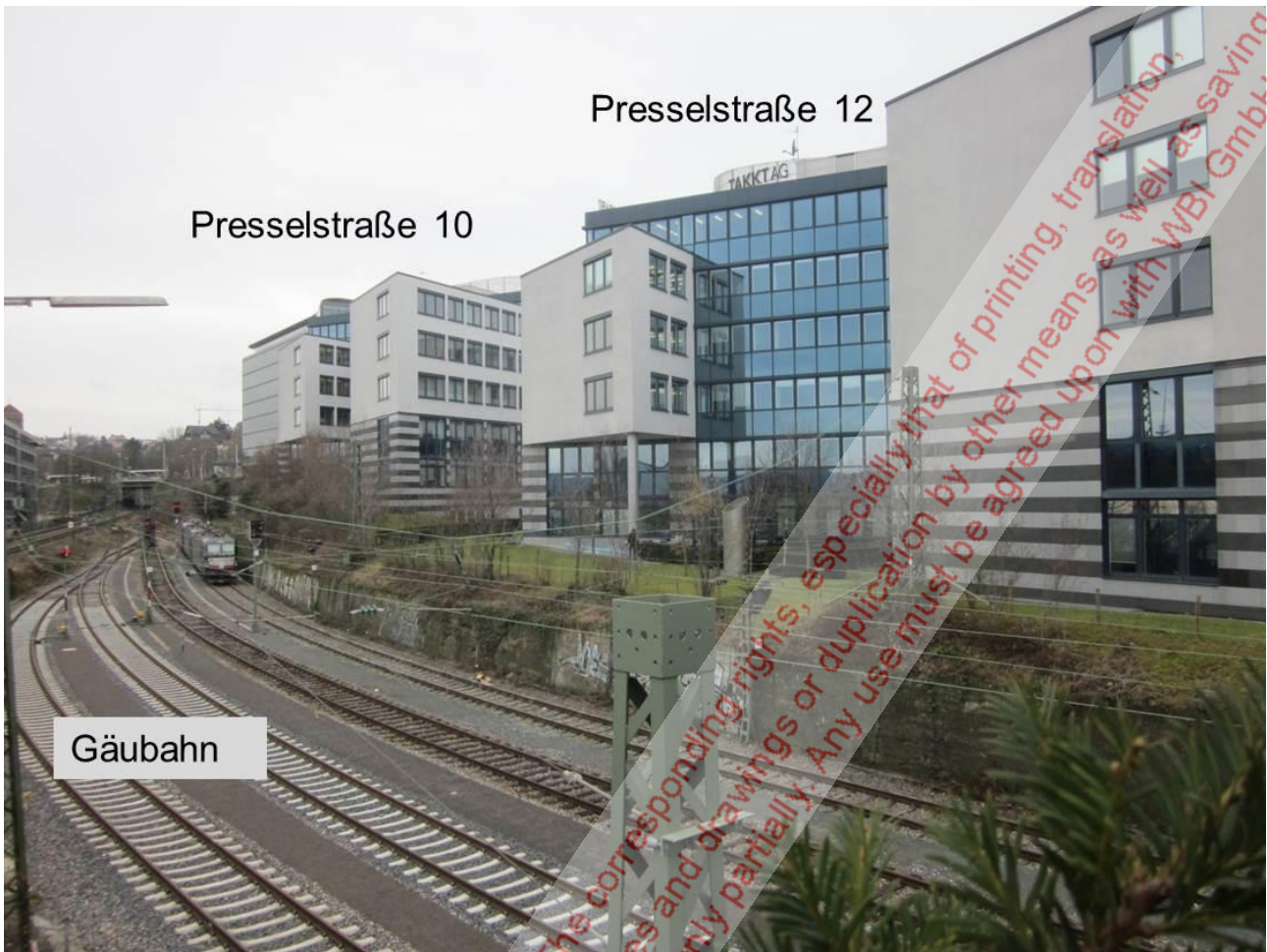
Bild 2: Gebäude Presselstraße 10 und 12
