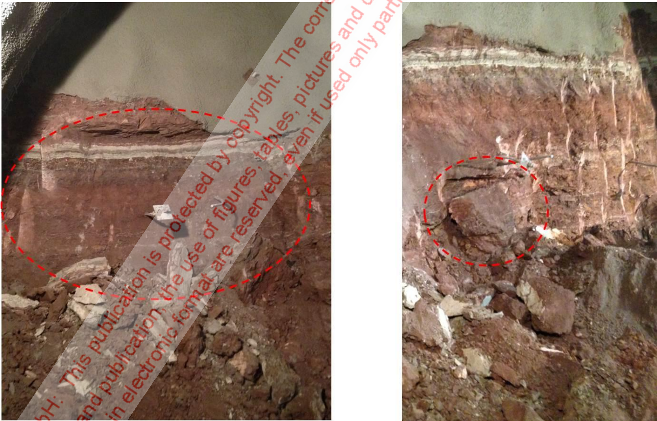
Bild 7: Herauslösen von Flächen aus der Ortsbrust
