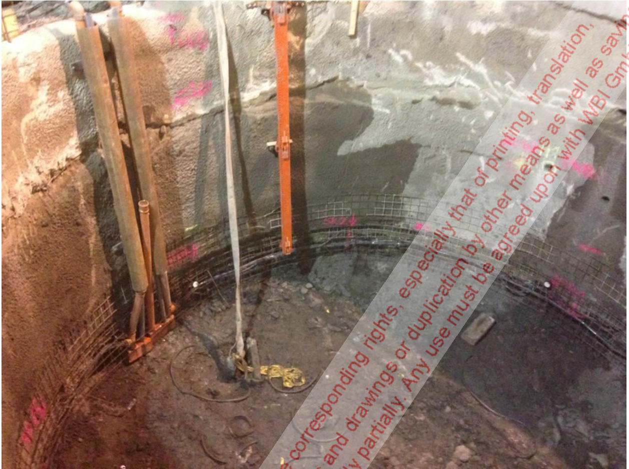
Bild 21: Blick in den Erkundungsschacht
