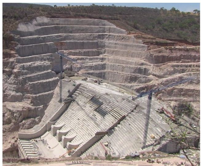
Bild 5: Blick auf die Staumauer vom linken Widerlager in 2014
