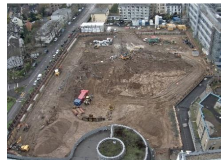
Bild 1 Baugrube Uniklinik Köln
